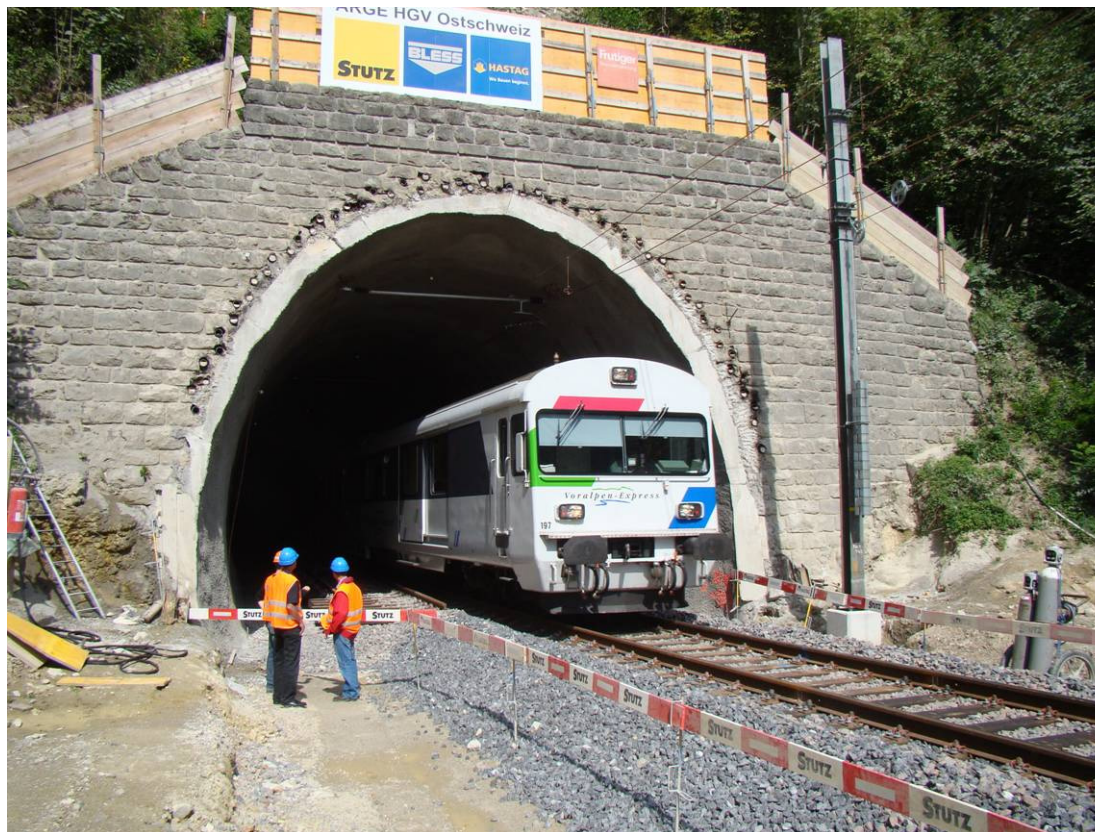
Bild: Südportal Bruggwaldtunnel, 7.9.09
