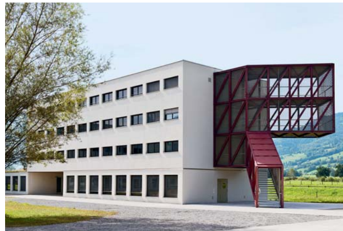
Die Strafanstalt Saxerriet hat ihr Platzangebot mit einer geschlossenen Übergangsabteilung ergänzt und eine Lücke im Vollzugsangebot geschlossen.
