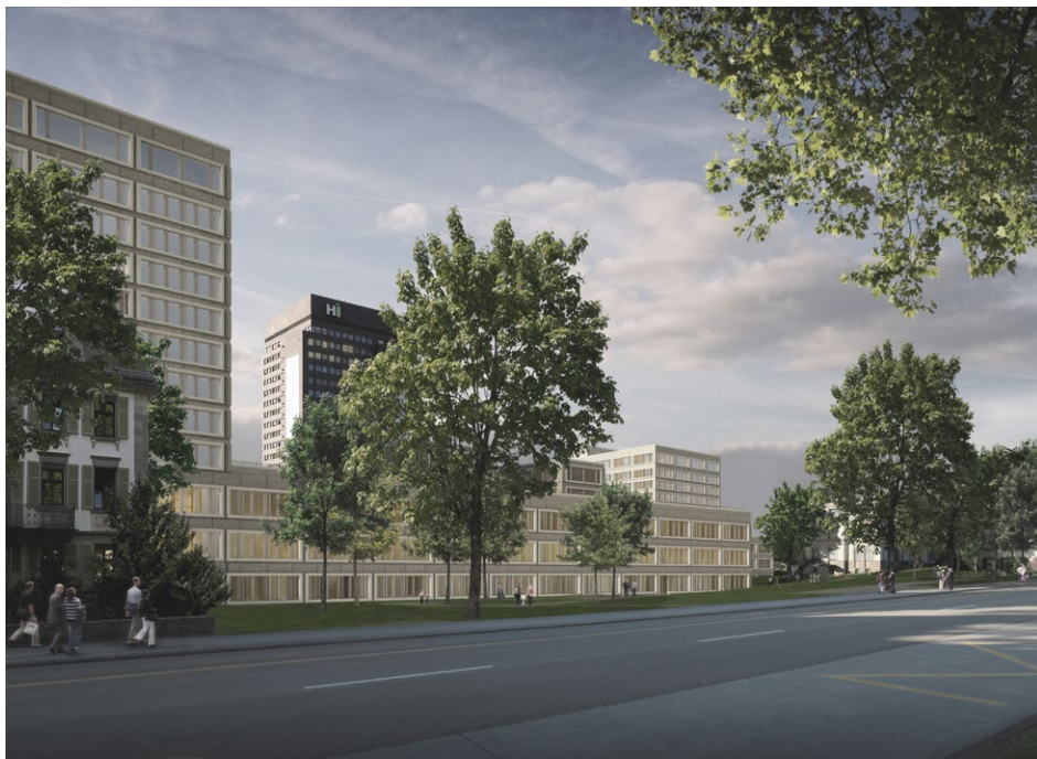
Modelldarstellung des erneuerten KSSG-Areals
