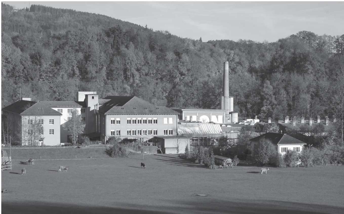
St.Gallen Sittertalstrasse 34. (Bild: zVg Denkmalpflege der Stadt St.Gallen)
