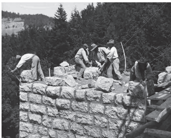
Arbeiter beim Bau eines Brückenpfeilers des Aesch-Viadukts der Bodensee-Toggenburg-Bahn zwischen Degersheim und Mogelsberg, ca. 1909. (Bild: zVg Staatsarchiv Kanton St.Gallen)
