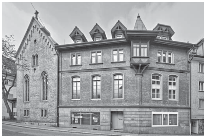
Gebäude Katharinengasse 21, St.Gallen Foto: zVg Kantonale Denkmalpflege
