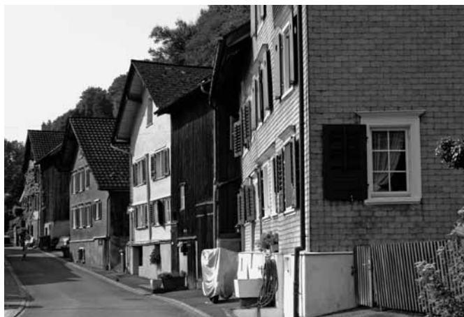
Sevelen, Völsli, Ortsbild von kantonalen Bedeutung. (Bild: kantonale Denkmalpflege)
