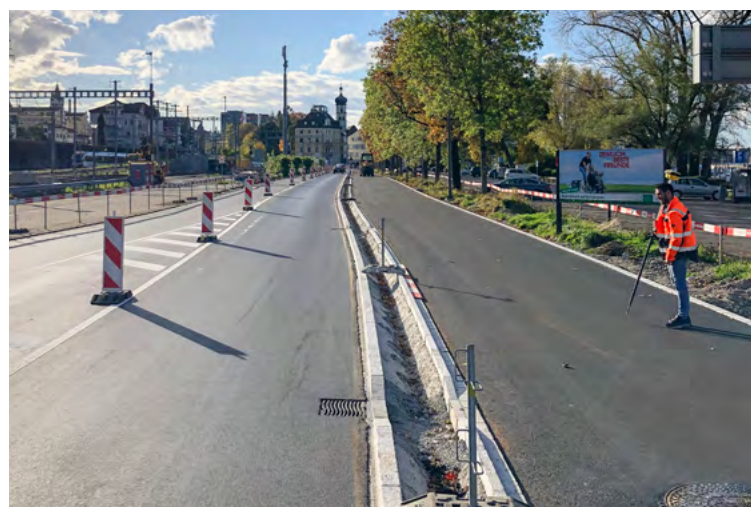
An der Churerstrasse in Rorschach entstand ein neuer kombinierter Geh- und Radweg.
