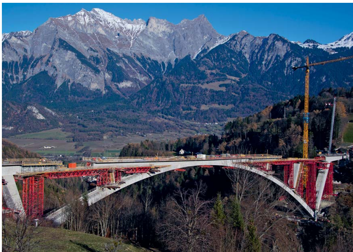
Nach dem Bogenschluss im März 2015 wurde mit dem Bau der 417 Meter langen Fahrbahn der Taminabrücke begonnen. (Foto: Fetzner, Bad Ragaz)
