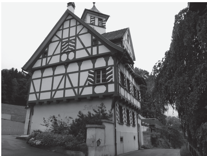
St. Gallen, Falkenburgstrasse 25, Ostfassade vor Renovation 2009. (Bild: zVg Kantonale Denkmalpflege)
