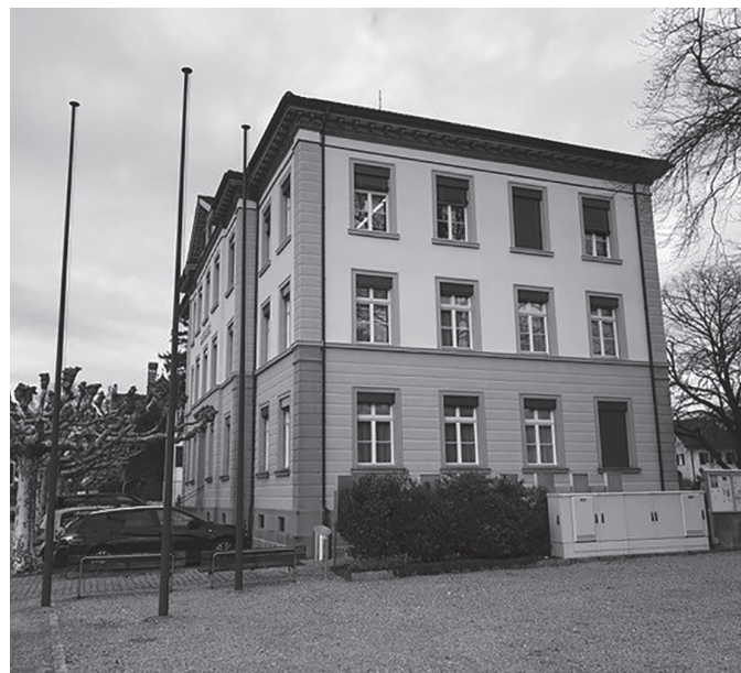
Oberriet, Rathaus. (Bild: zVg Kantonale Denkmalpflege)
