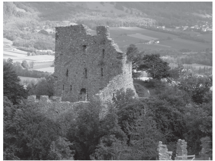
Burgruine Wartenstein in Pfäfers. (Bild: zVg Kantonale Denkmalpflege)
