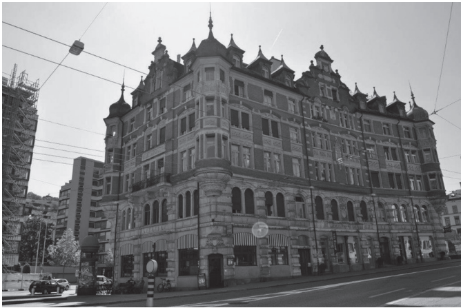
St. Gallen, Rorschacherstrasse 32, 34, Nordfassade 2016. (Bild: zVg Kantonale Denkmalpflege)
