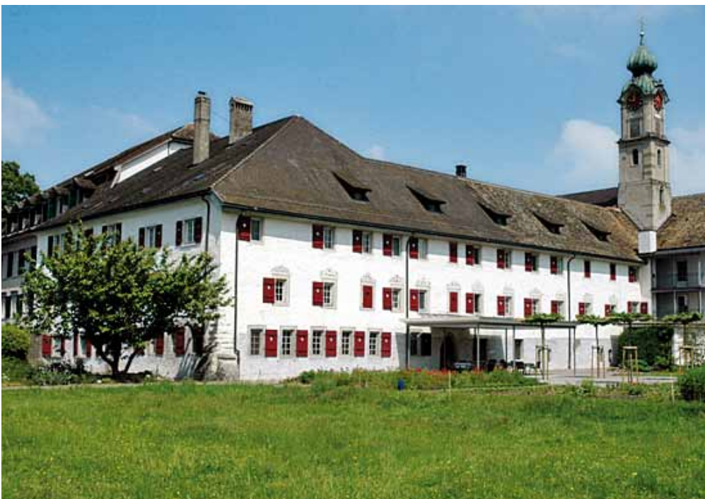
Kloster Wurmsbach Bollingen, Rapperswil-Jona (Bild: Kant. Denkmalpflege)
