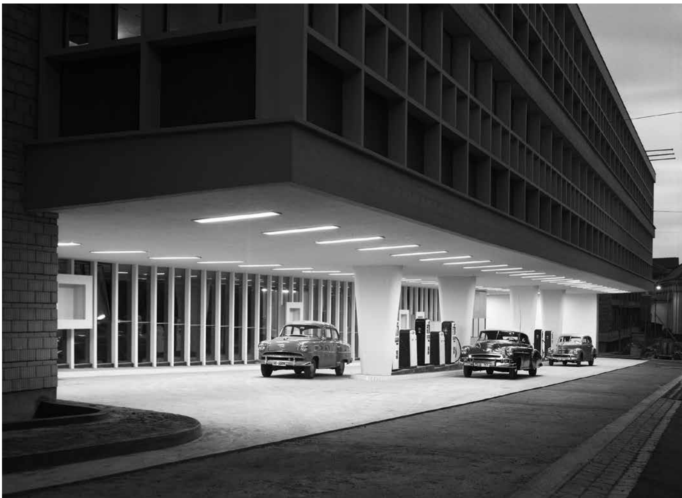
Centralgarage in St.Gallen, Architekt Ernest Brantschen, 1953–55. Zapfsäulen am Unteren Graben. (Bild: Foto Gross, Stadtarchiv der Ortsbürgergemeinde St.Gallen; zVg Katrin Eberhard)
