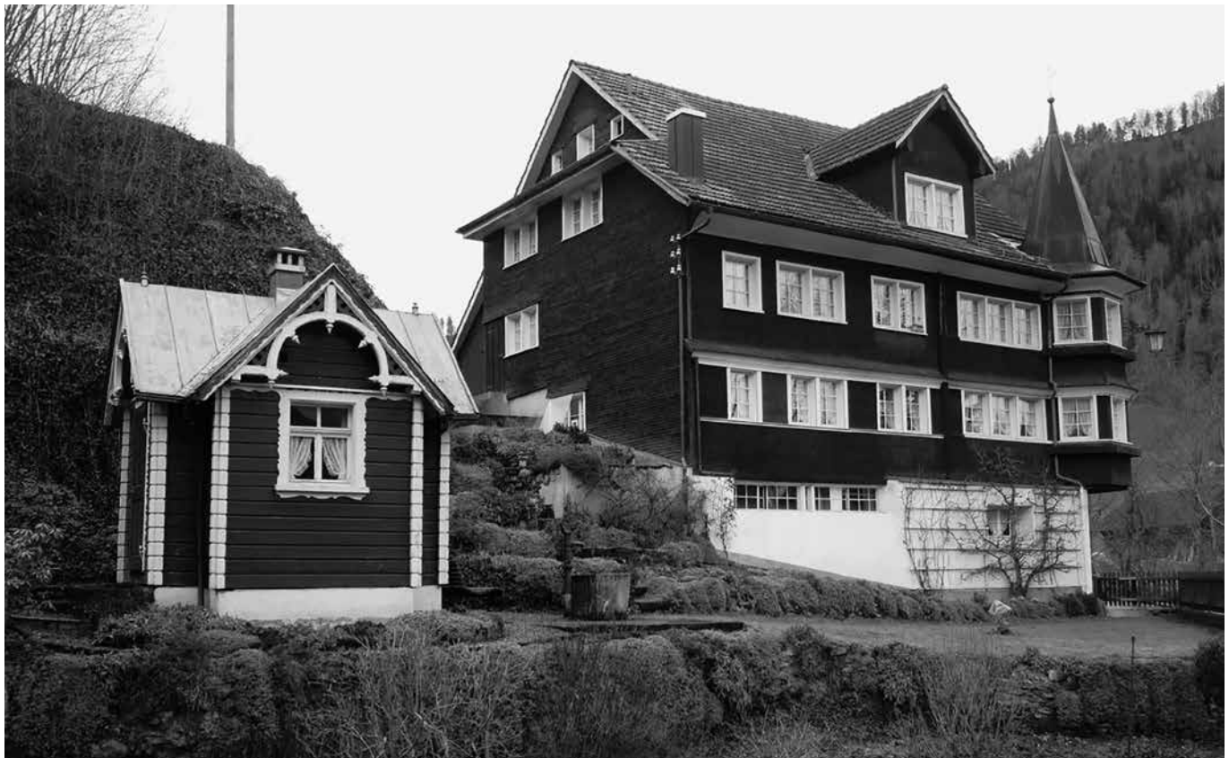
Das ehemalige Gasthaus Hirschen in Brunnadern. (Bild: zVg Kantonale Denkmalpflege)
