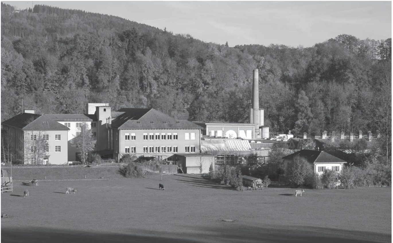
St.Gallen Sittertalstrasse 34. (Bild: zVg Denkmalpflege der Stadt St.Gallen)
