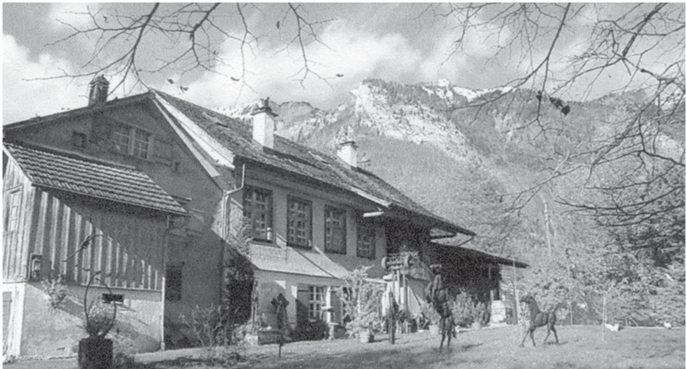
Alte Hammerschmiede in Sennwald (Bild: Kantonale Denkmalpflege)
