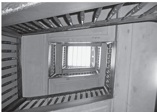
Treppenhaus im Lichtensteiger Haus Bären. (Bild: zVg Kantonale Denkmalpflege)
