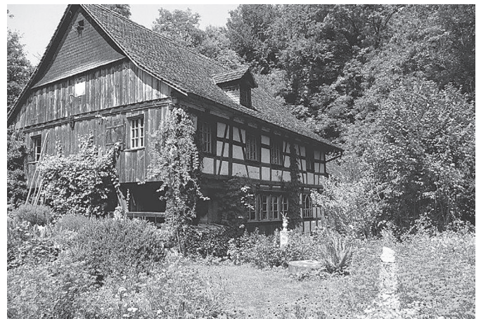
Das Haus Kobesenmühle in Niederhelfenschwil. (Bild: zVg Kantonale Denkmalpflege)
