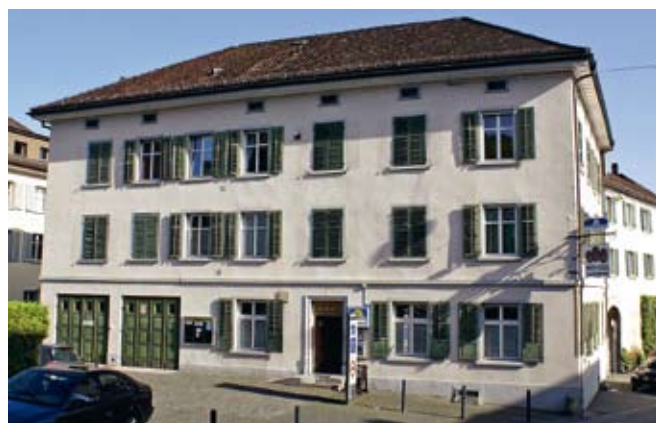
Der Nordflügel des Ensembles soll saniert und die «Prestegg» in ein Zentrum für Kultur und Geschichte umgewandelt werden. (Bild: Kantonale Denkmalpflege)
