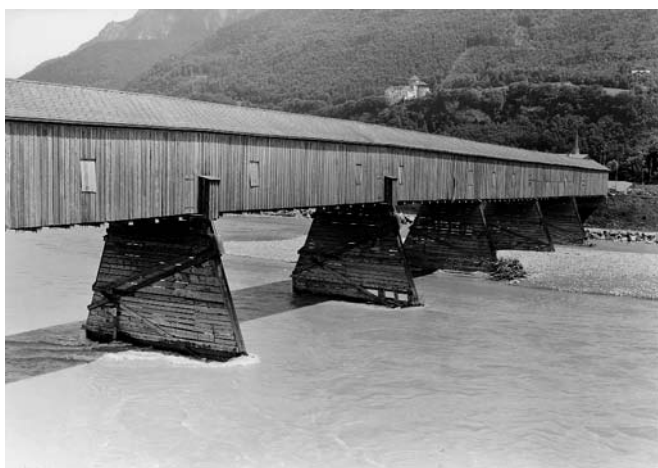
Alte Rheinbrücke Sevelen
