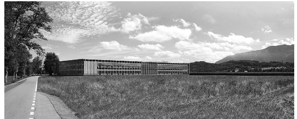
Das Projekt Teilabbruch und Ersatzneubau der Landwirtschaftsschule am LZSG in Salez
